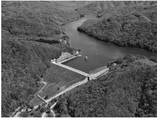
厚真ダム 昭和37年～昭和45年の9ヶ年で完成
