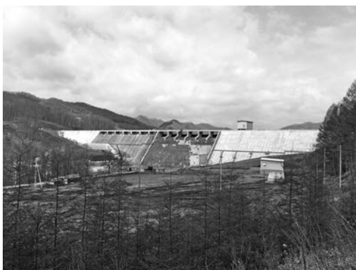
厚幌ダム平成31年完成
